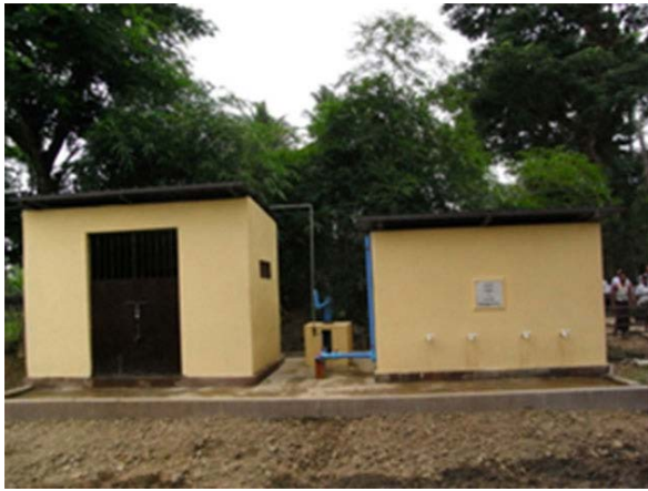
完成した井戸設備 (左が機械棟、中が手押しポンプ、右が水槽棟)
